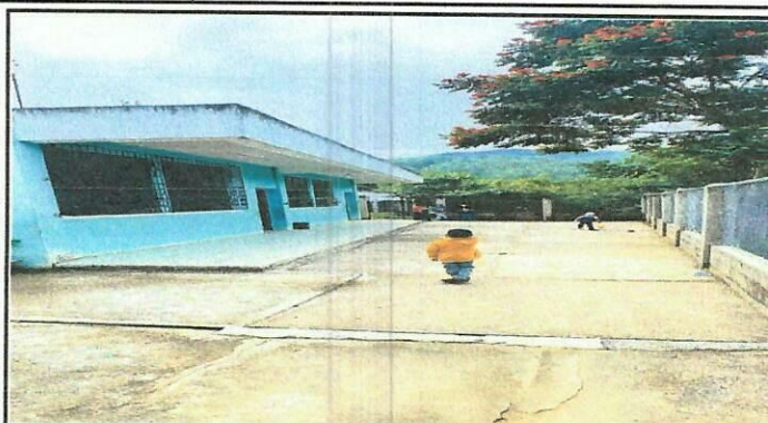
Foto 2: Mejoramiento de pintura de la escuela
