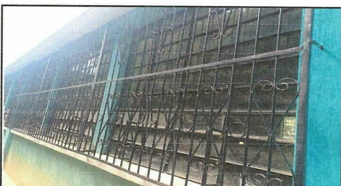
Foto 4: Mejoramiento de pintura de balcones
