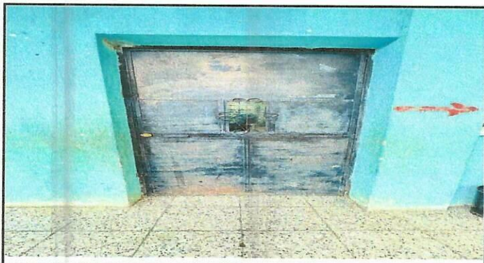
Foto 3: Mejoramiento de pintura de puertas
