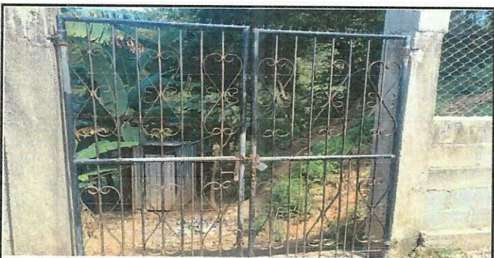
Foto 5: Mejoramiento de pintura de portones
